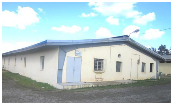
Figure 5.1: Bâtiment de l'élevage (cunicole).
