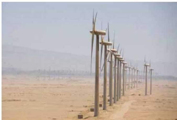
FIGURE 1.3: Mise en service de la ferme éolienne d'Adrar
