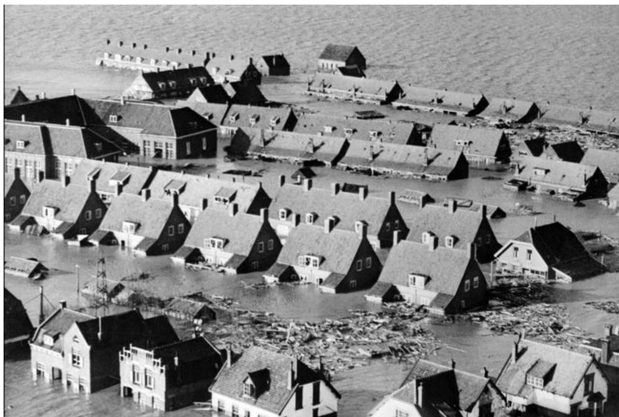
FIGURE 1 – Vue aérienne d’Oude Tonge, au nord de la Zélande, le 3 février 1953, après le raz-de-marée qui a causé 2 500 morts, 47 000 habitations inondées et 10 000 détruites, 200 000 hectares de terres inondées, 30 000 têtes de bétail noyées. Source : Wikipédia.
