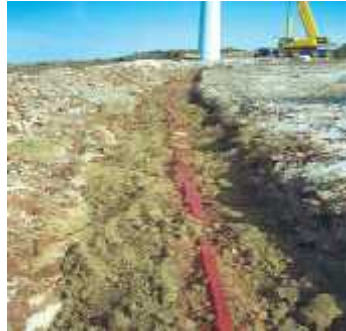
Figure I.10 : Enfouissement des câbles de raccordement électrique
