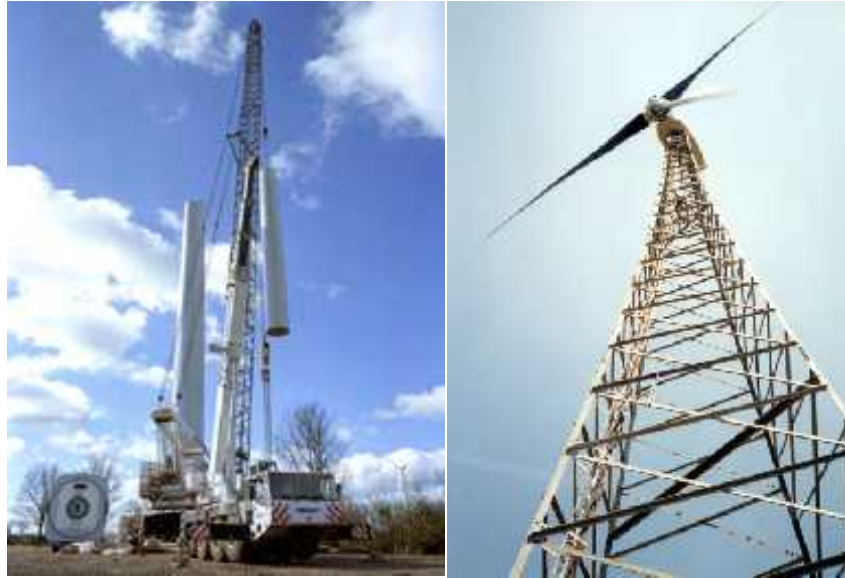
Figure I.11.a : Montage d'un mât tubulaire
