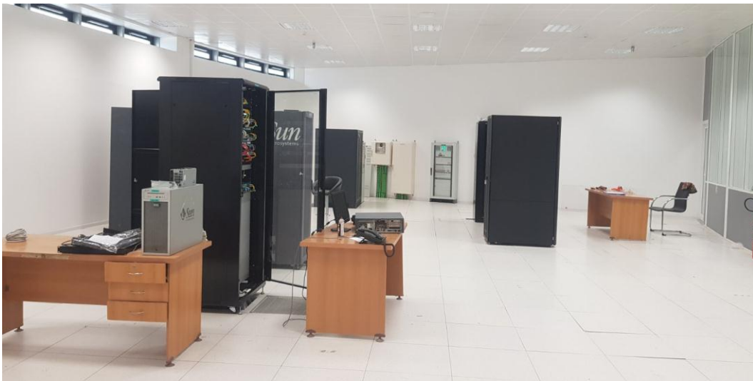
Figure IV.3 : La nouvelle installation de réseau.
