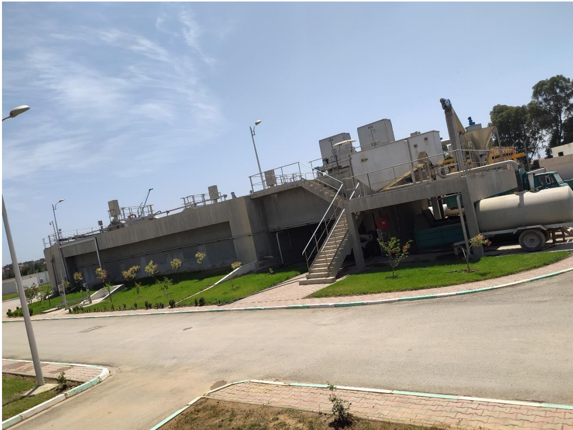
Figure 2.2: Poste de pré-Traitement de la STEP de Boufarik
