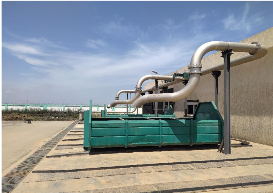
Figure3.25. Les bennes de stockage des boues de la step de Boufarik
