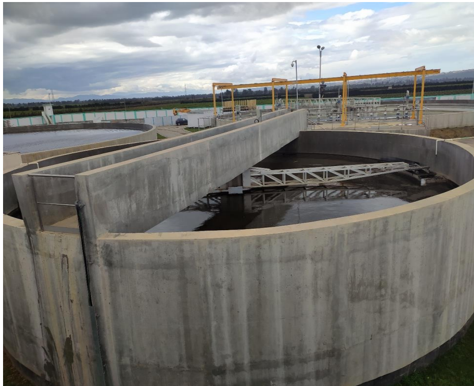
Figure 3.13. Dégazeur de la step de Boufarik
