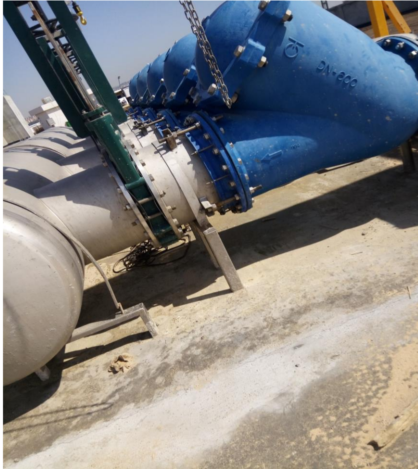
Figure 3.2. Collecteur DN-600 de la Step de Boufarik
