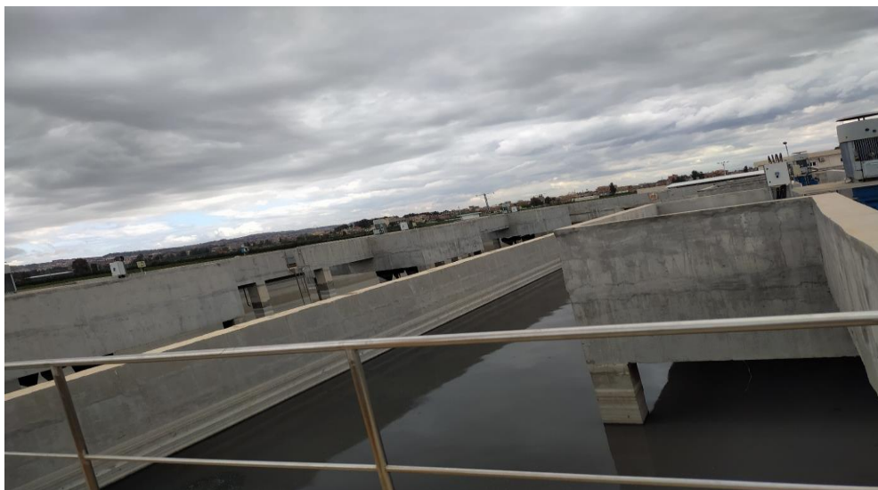
Figure 3.18. Bassin de stabilisation des boues
