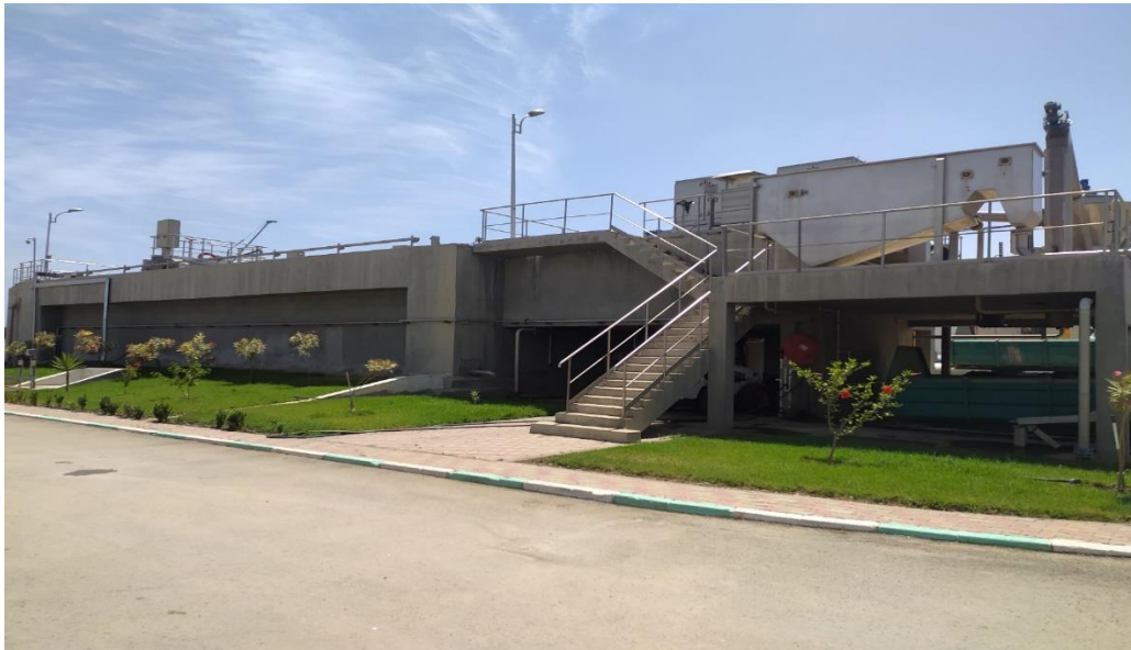
Figure 3.5. Poste de prétraitement de la station d'épuration de la ville de Boufarik
