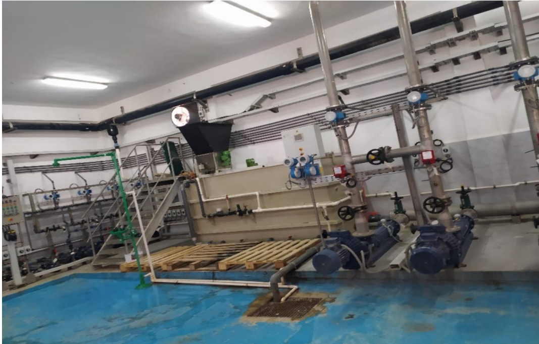
Figure 3.23. Préparation du polymère en poudre
