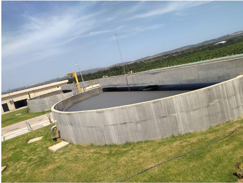
Figure 3.17. Les deux épaisseurs de la step de Boufarik
