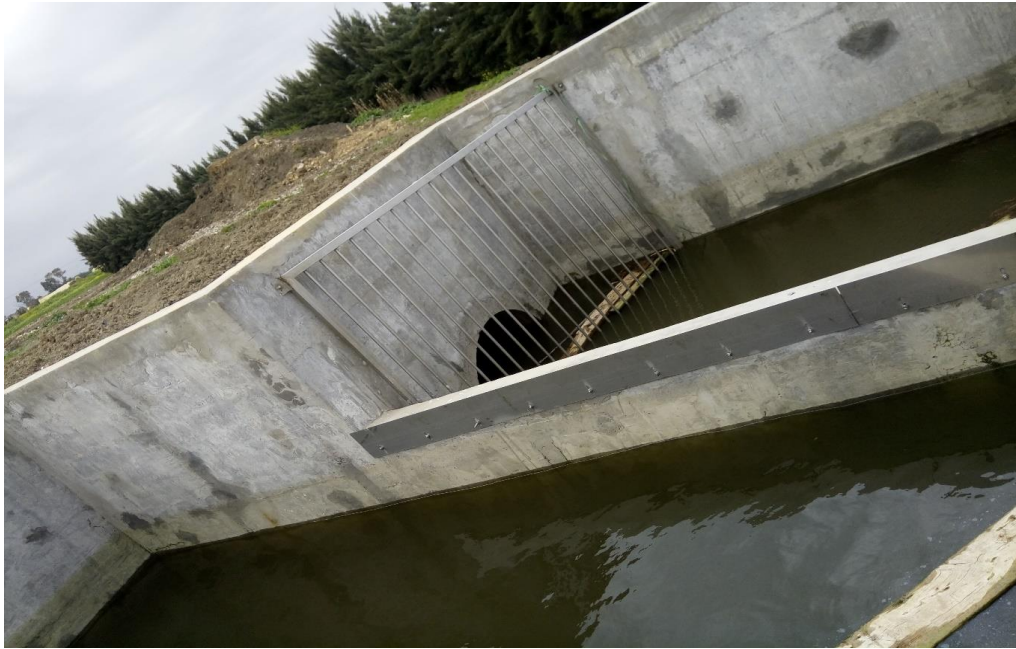
Figure 3.3. Poste de réception des eaux usées arrivant de Ain-Aicha
