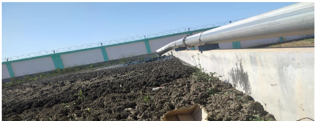
Figure 3.24. Air de stockage des boues de la station de Boufarik
