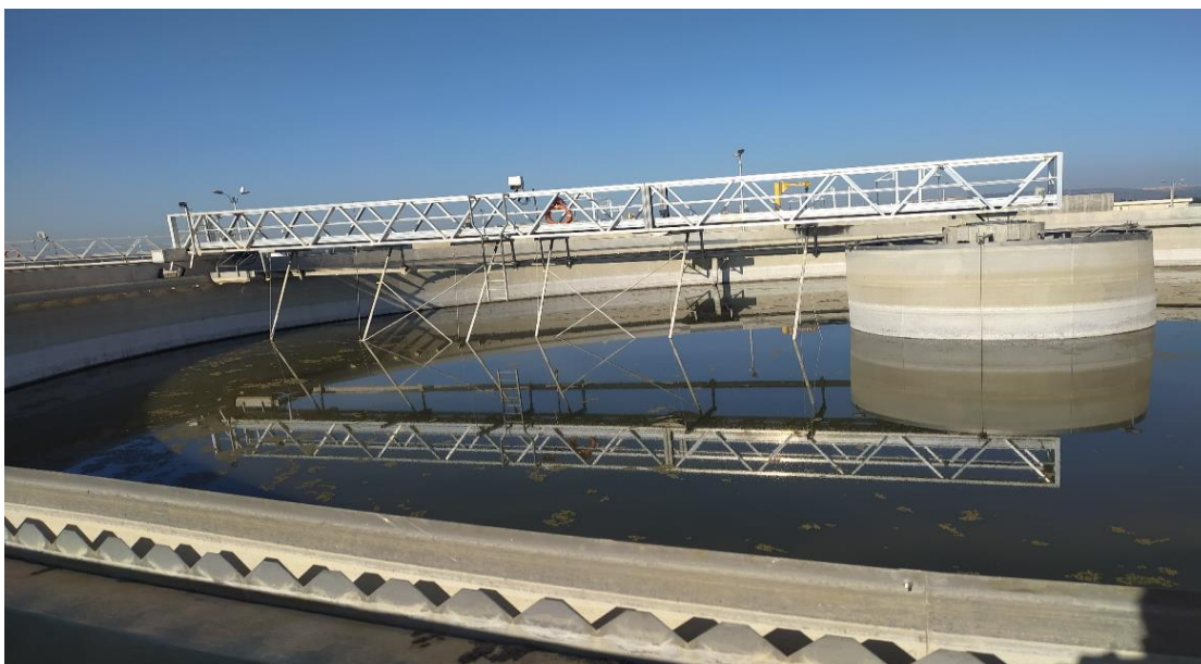
Figure 2.5 : décanteur primaire de la station d'épuration de Boufarik
