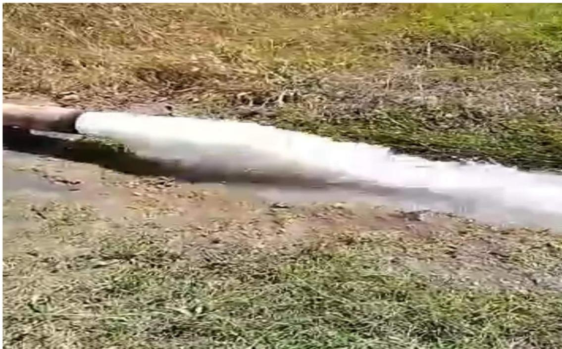
**Figure 54:** développement à l'air lift (pneumatique), compresseur 40bar.
