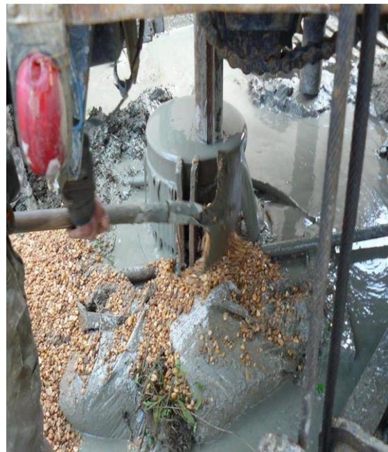
**Figure 51:** mise en place du massif filtrant
