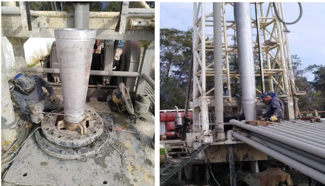
Figure 50: cône de réduction
