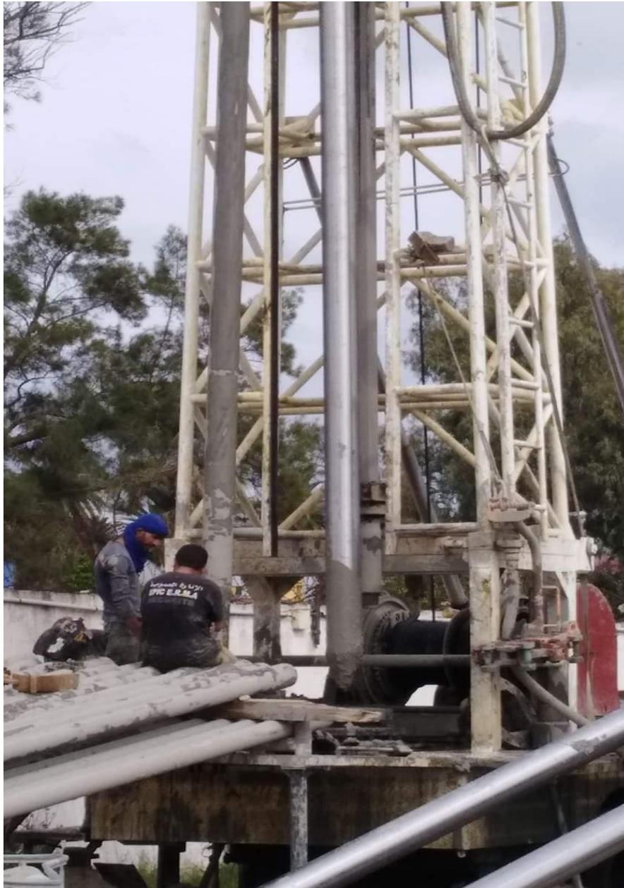
**photo 48** : tube décanteur avec sabot
