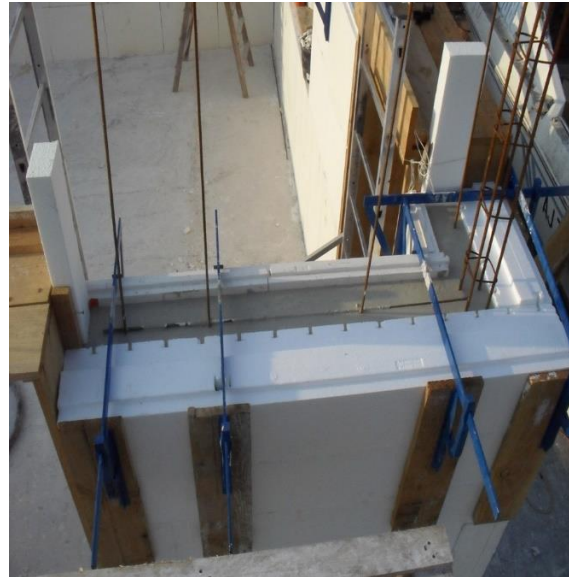
Figure 1- 9 : coffrage à béton isolé.
