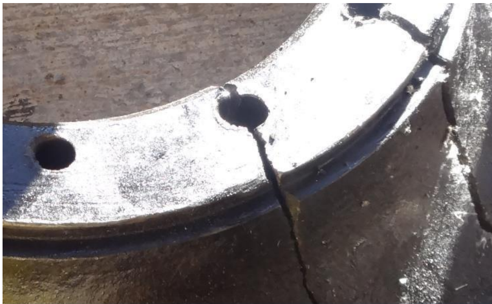
Fig. IV.1 : Rupture brutal du diaphragme
