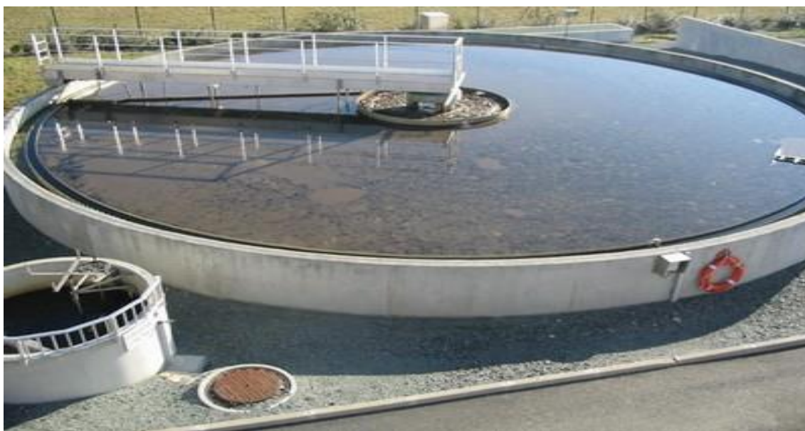
Figure I.7 : Photo numérique qui représente un bassin de décantation
