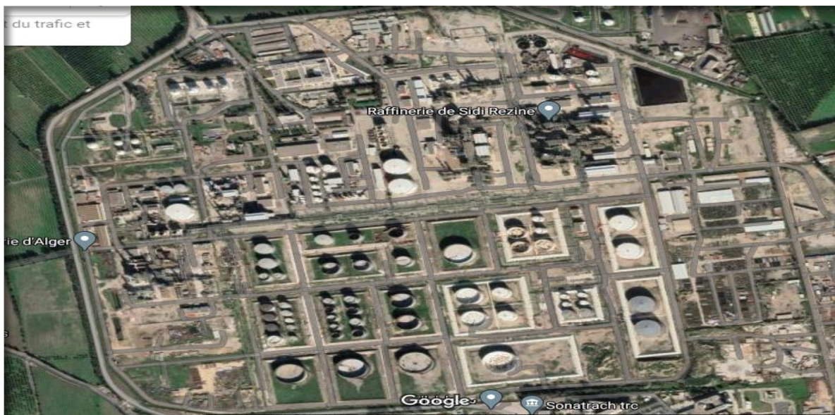
Figure II.1 : Photographie montrant la situation géographique de la raffinerie d'Alger SONATRACH
