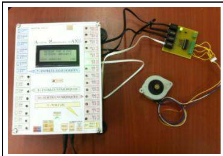
Figure 3. 38 : raccordement du moteur pas à pas avec l'automate
