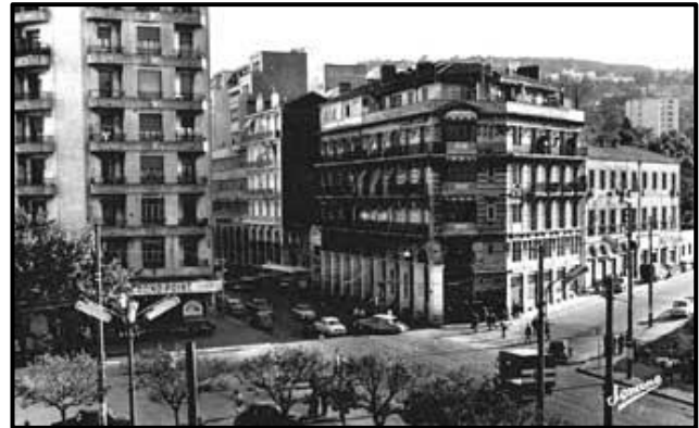
Fig.10 : Les HBM du Champ de Manœuvre, Alger http://www.babelouedstory.com/voix_du_bled/champmanoeuvre/manoeuvre.html
