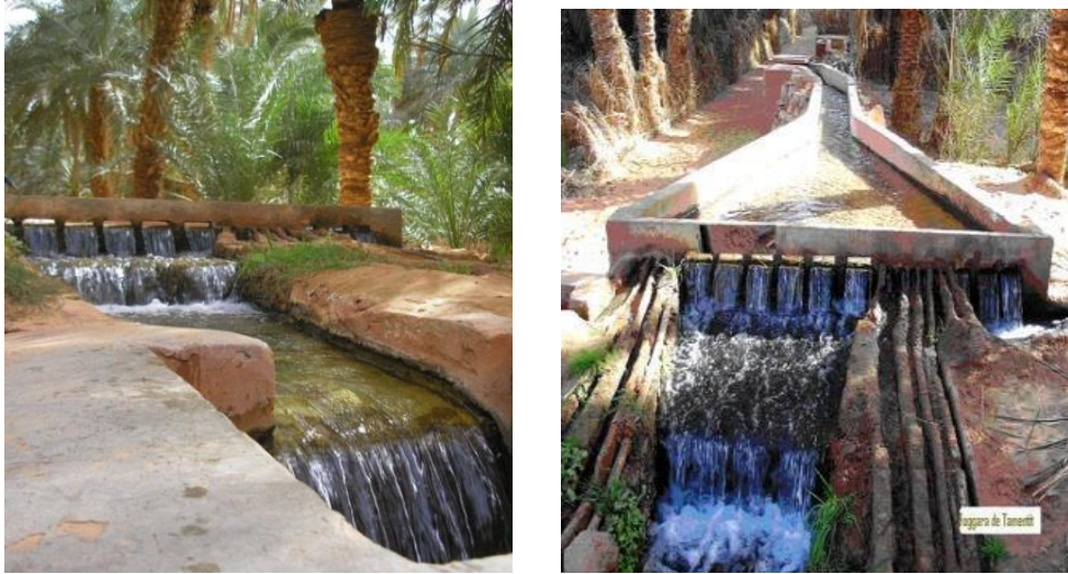
Figure 2.17 : Alimentation en eau par Foggara (les Oasiens).
