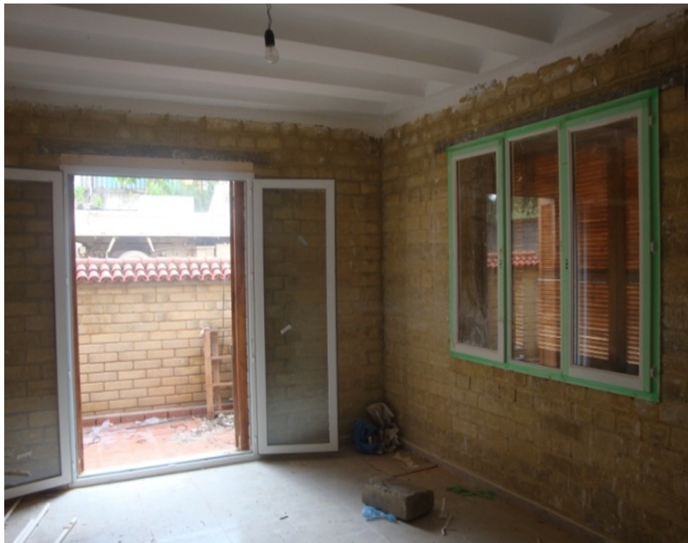
FIGURE 2.4 – La mise en place des fenêtres a double vitrage
