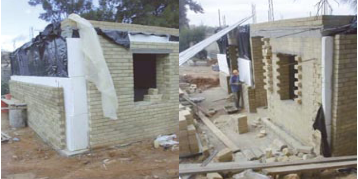
FIGURE 2.9 – Les murs extérieurs avec isolation
