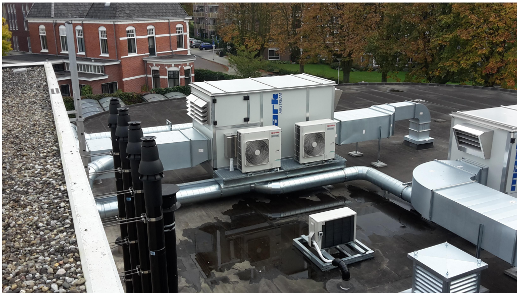
FIGURE 1.12 – exemple d'une ventilation active [8]
