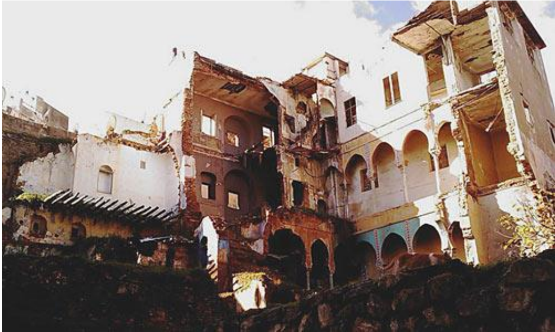
Figure II.9 : Un exemple de démolition d'une maison à la Casbah d'Alger.
