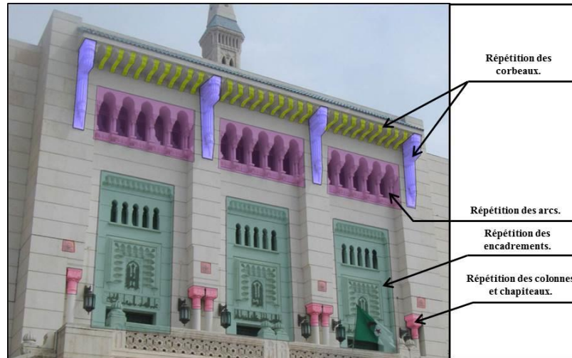
Figure 5. 20. Le rythme et la répétition sur la façade de l'accès postérieur. (Source : Auteur).
