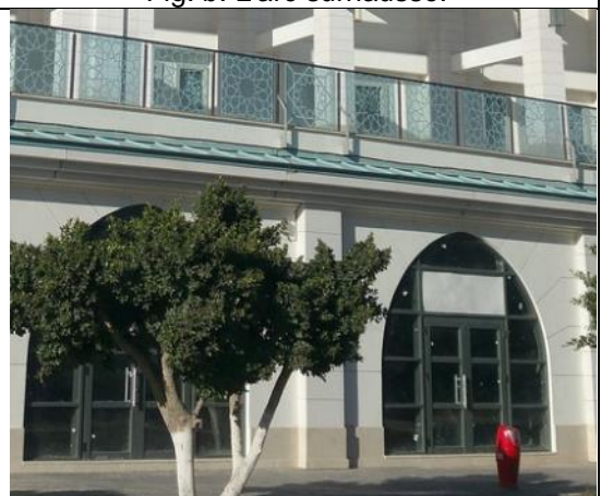
Fig. d. Arc plein cintre brisé.
