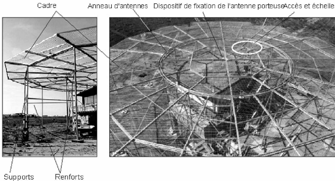
Figure 3.6 : Supports et cadre, exemple d'installation.
