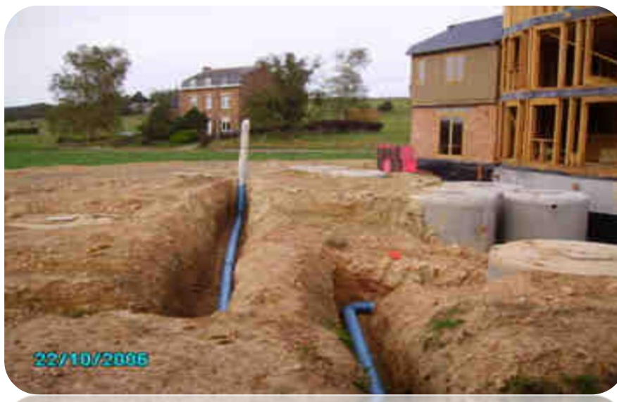
Figure 4.39 : construction d'un puits canadien ; les gaines de ventilation sont installées dans les tranchées d'une maison en construction près de Floreffe(France) [30]
