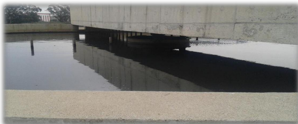
Photo N° 10 : Epaississeurs des boues
