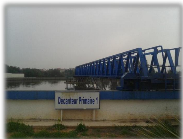
Photo N° 4: Décanteur primaire 1
