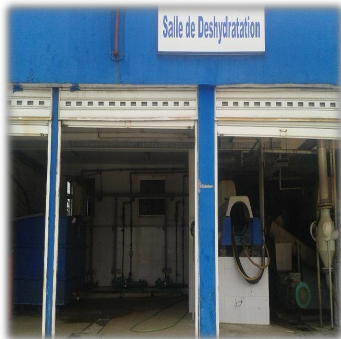
Photo N°12 : salle de déshydratation
