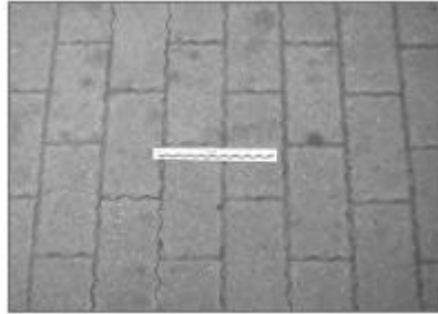
Figure A.10 Revêtement de pavé artificiel.
