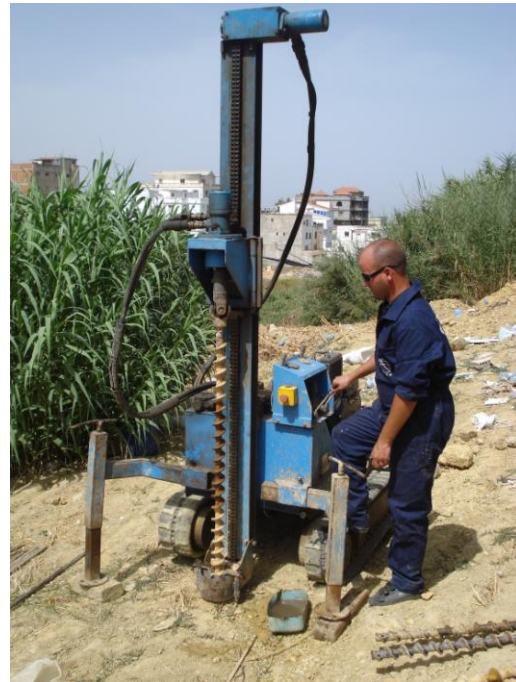
Figure 1.4 : Forage à la tarière mécanique
