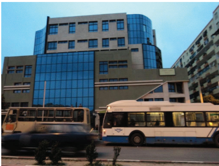
Figure.3.16 Irrégularité en plan retrait en façade
