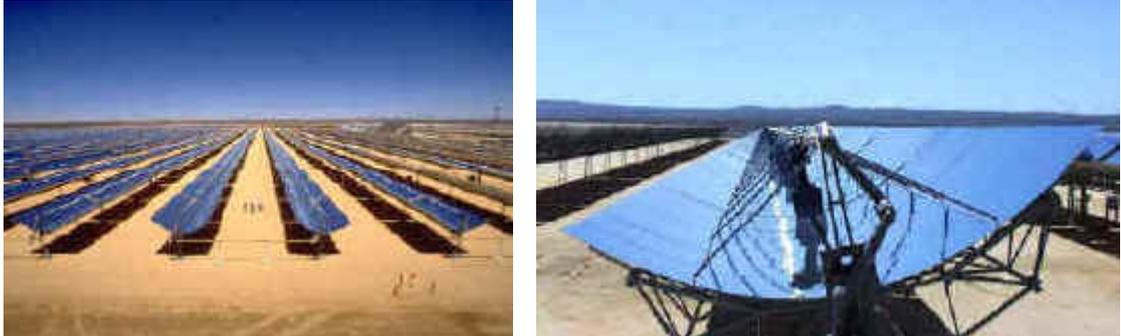
Figure 1.6 : Concentrateurs solaires utilisés pour la centrale hybride gaz-solaire
