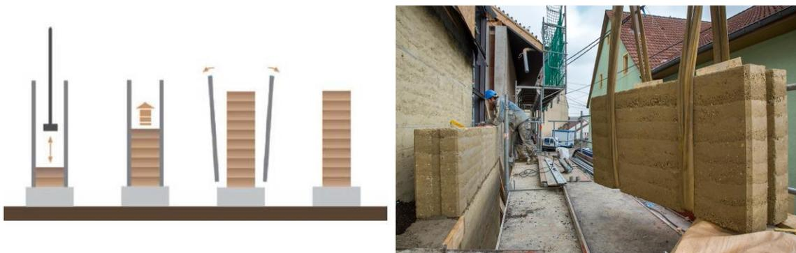
Figure 1.14 : Construction en pisé [12].
