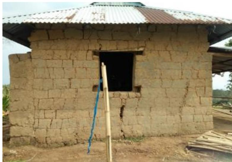
Figure 1.19 : Construction en terre avec de nombreuses fissures de retrait [15].
