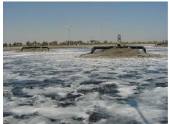
Figure I. 3 : photo (a) : bord d'une lagune aérée photo (b) : aérateurs de surface amarrés
