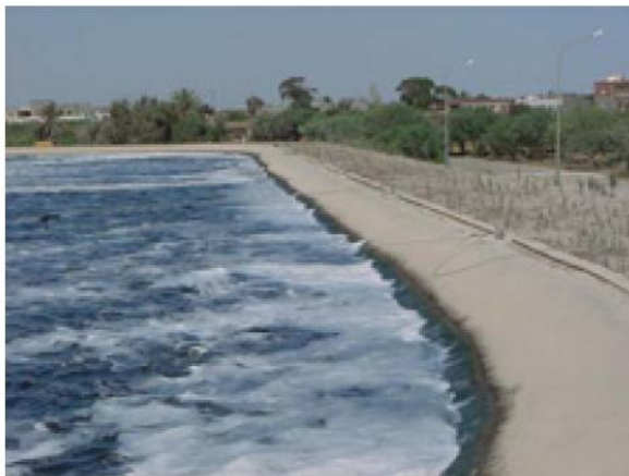
Figure I. 3 : photo (a) : bord d'une lagune aérée photo (b) : aérateurs de surface amarrés
