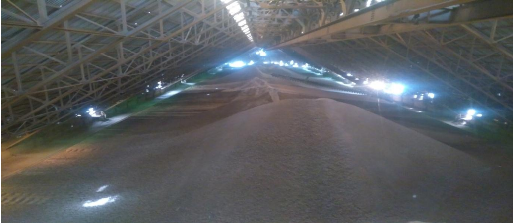
(Figure 2.12) : Hall de stockage
