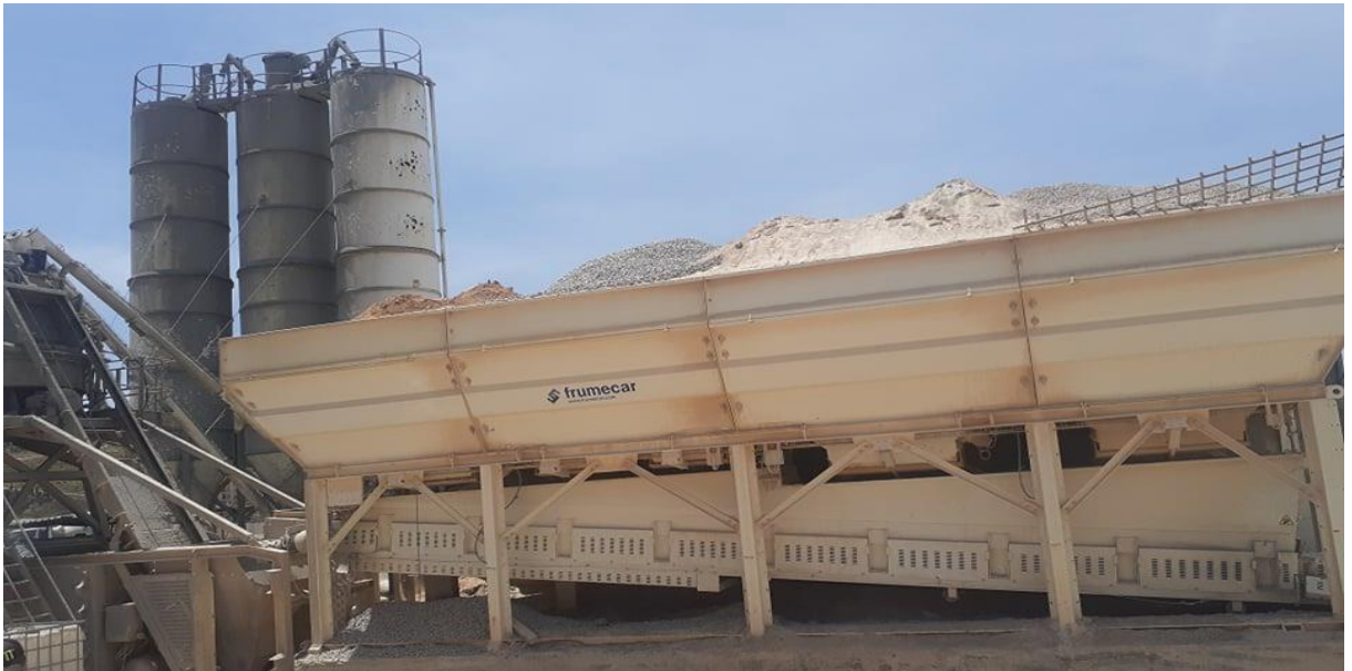
Figure 2. 3: L'installation des matériaux utilisés.
