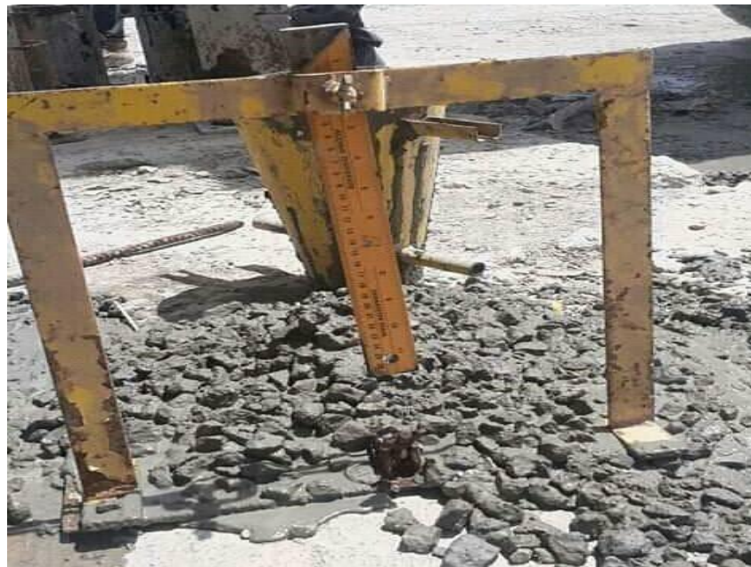
Figure 2. 22: Mesure de l'affaissement de béton.
