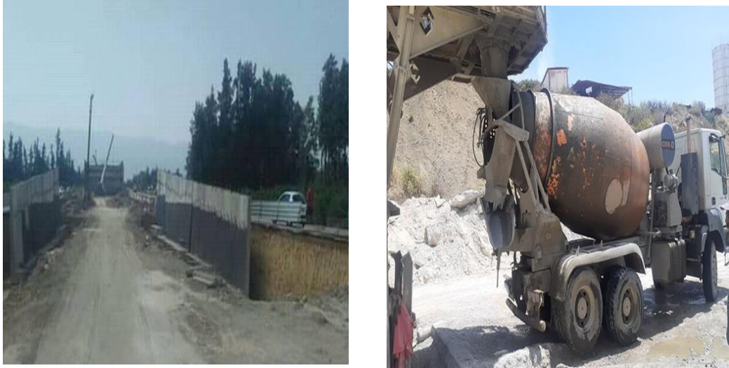
Figure 2. 1(b) : Vue du projet N°1 et du camion malaxeur.
