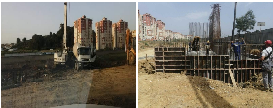
Figure 2.2 (a) : Vue générale du projet N°2 et du bétonnage en cours.
