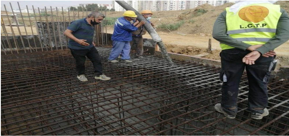
Figure 2. 2(b) : Vue du bétonnage en cours du projet N°2.
