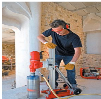
Fig. 2.3 : Essai de carottage
