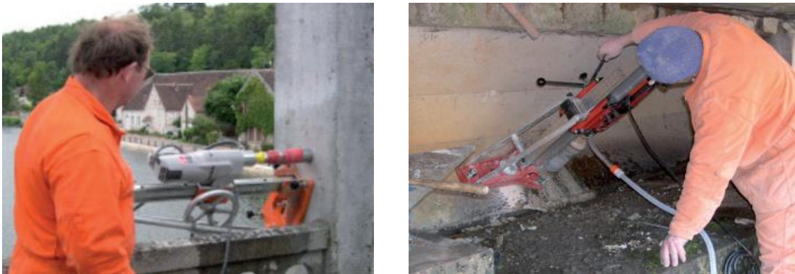
Fig. 2.4 : Méthode de carottage
