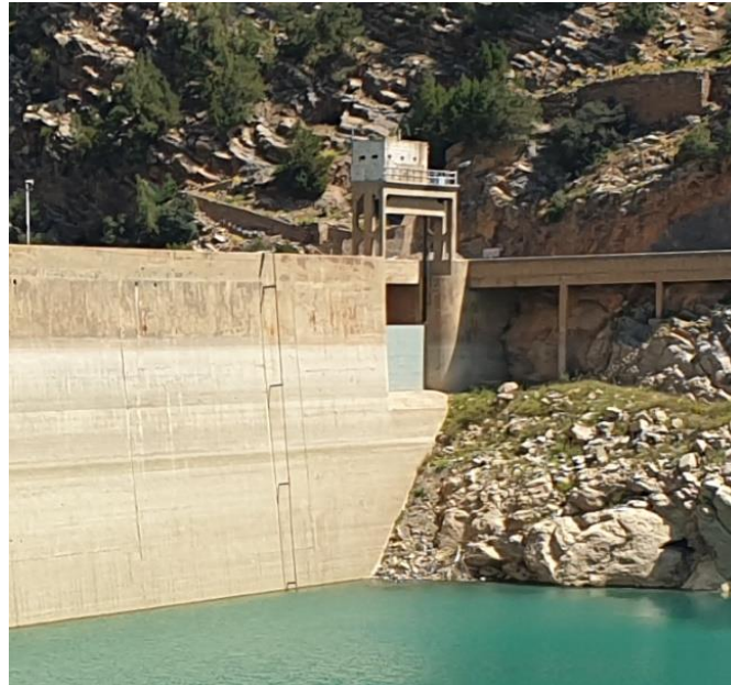
Figure 2. 8 : l'amont de l'évacuateur Complémentaire (Photo : B. ABBAS, avril2021)
