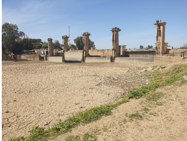
Figure 2. 6 : Barrage en l'aval de barrage Oued Fodda (Photo : B. ABBAS, avril2021)
