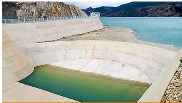
Figure 2. 13 : Evacuateur des crues [38].
