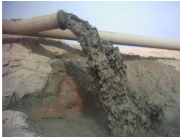
Figure 1. 13 : Rejet de la vase lors de l'opération de dragage de 2005-2006 [3].
