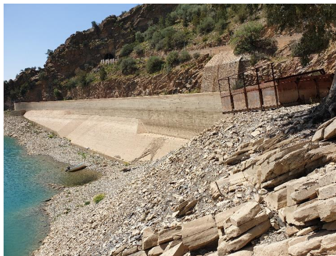
Figure 2. 7 : L'évacuateur de crues latéral (Photo : B. ABBAS, avril2021)
