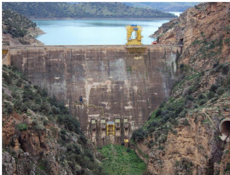
Figure 3. 15 : les 5 vannette de dévasement
