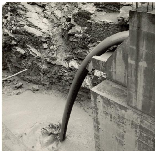
Figure 1. 11 : Dévasement du barrage Oued Fodda par la vanne de soutirage (Archives ANBT)
