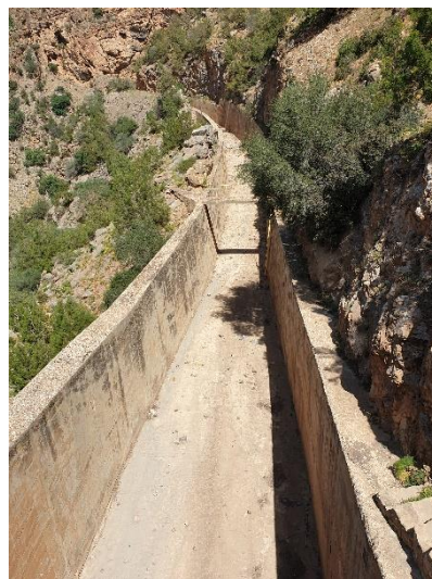
Figure 2. 9 : l'aval de l'évacuateur complémentaire (Photo : B. ABBAS, avril2021)
