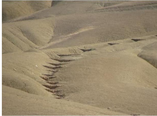
Figure 1. 8 : Une série de seuils réalisée sur une ravine du bassin versant de Beni Chougarne [3].
