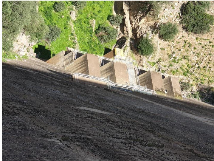
Figure 2. 10 : les 5 pertuis de dévasement (Photo : B. ABBAS, avril2021)
