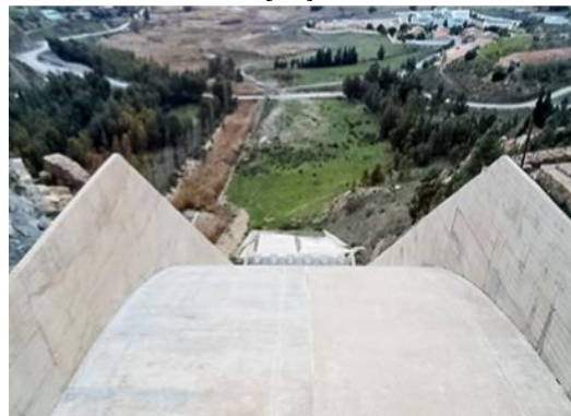
Figure 2. 14 : Evacuateur des crues [38].
