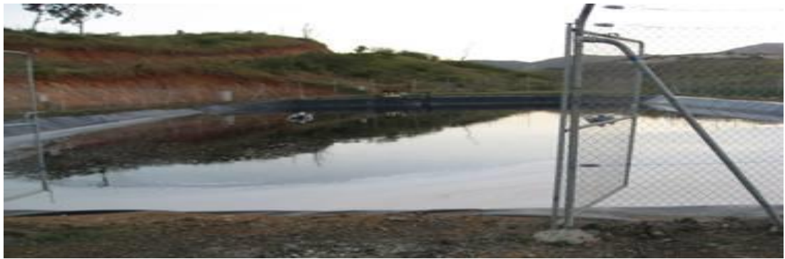
Figure II.3 : Bassin de stockage des lixiviats
