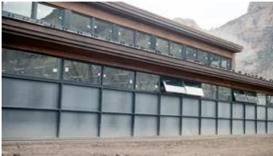
Figure 2. 5 : Mur Trombe du parc national Zion, Utah Etats Unis, étudié par Torcellini et Pless
