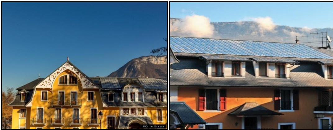
Figure I.8 : Toiture de l'hôtel Les Trésoms. [14]
