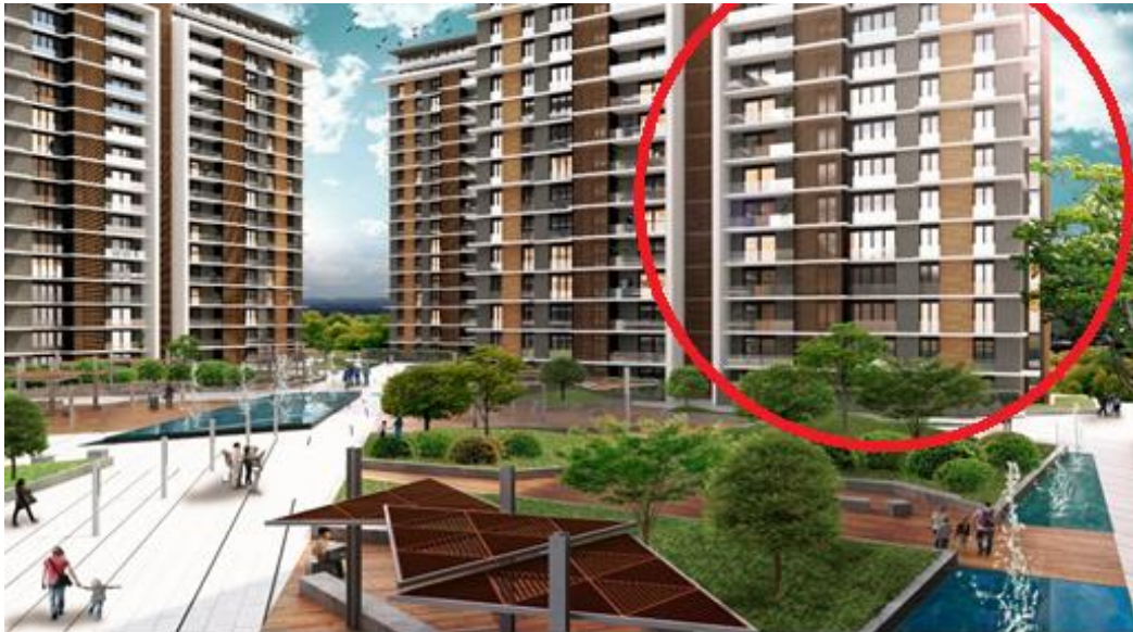
Figure 3.7 : Façade du bloc a étudié [59]
