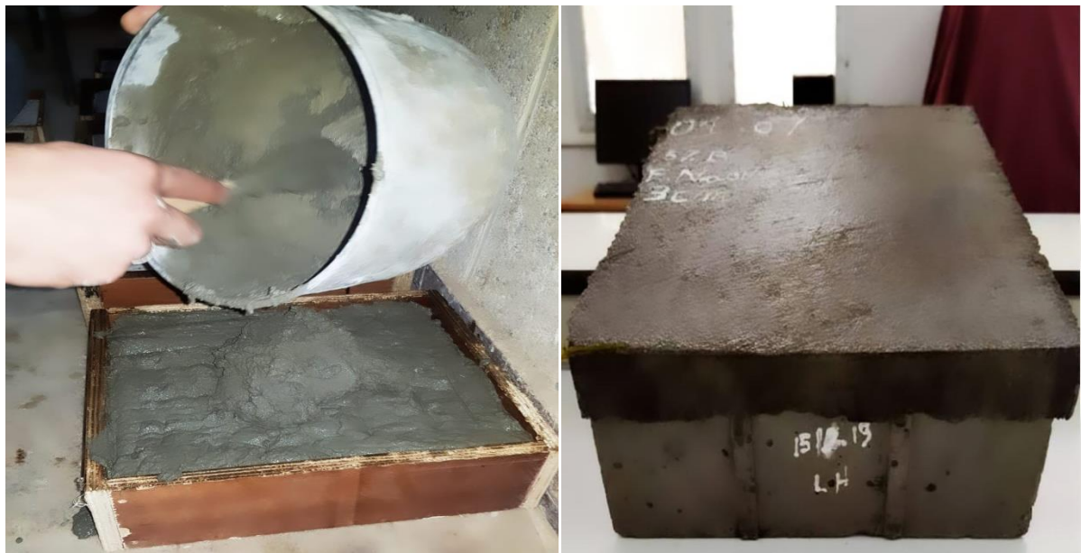
Figure 3-21: Application du mortier de réparation sur les dalles.
