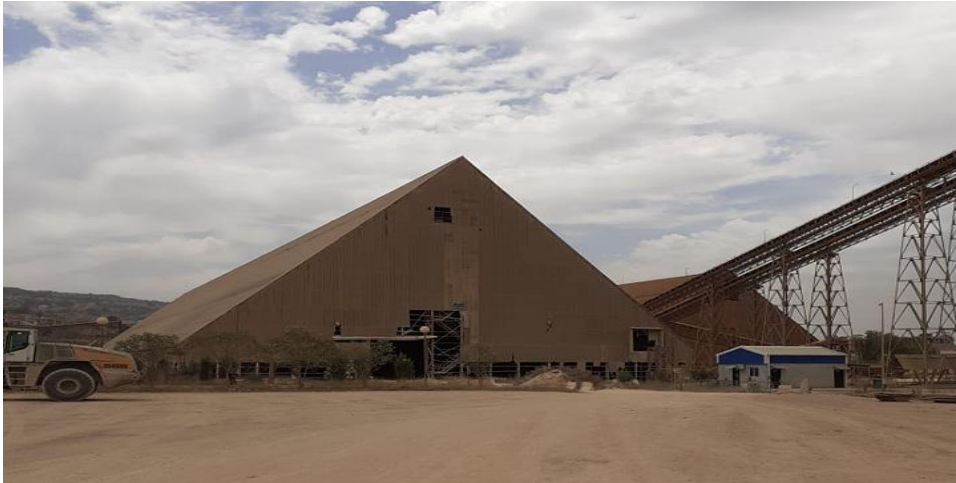
Figure I.9 : Hall de pré homogénéisation
