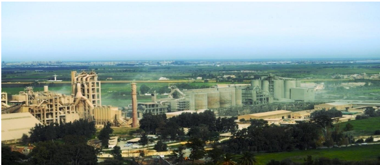
Figure I.1 : Vue générale de l'entreprise
