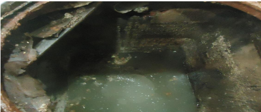
Figure 7. Photo de l'égout principal de l'hôpital de Brahim Tirichine (Fabourg).
