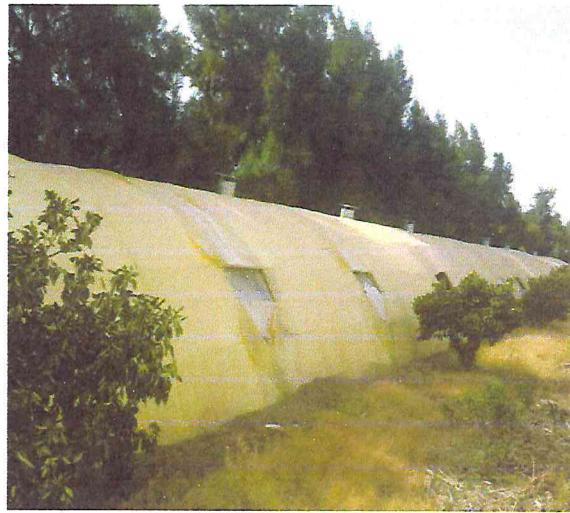
Photo 12 : Bâtiments d'élevage traditionnel
