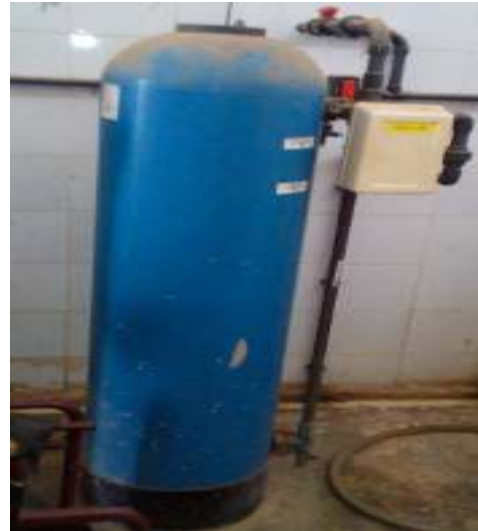
Figure 4 : Filtre à sable
