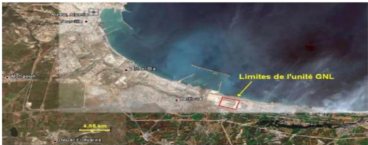
Figure 1.2 : Photo satellite du complexe GL3/Z
