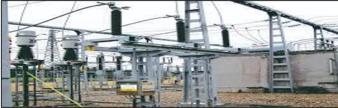
Figure 1.19 Sélectionneur mise à terre
