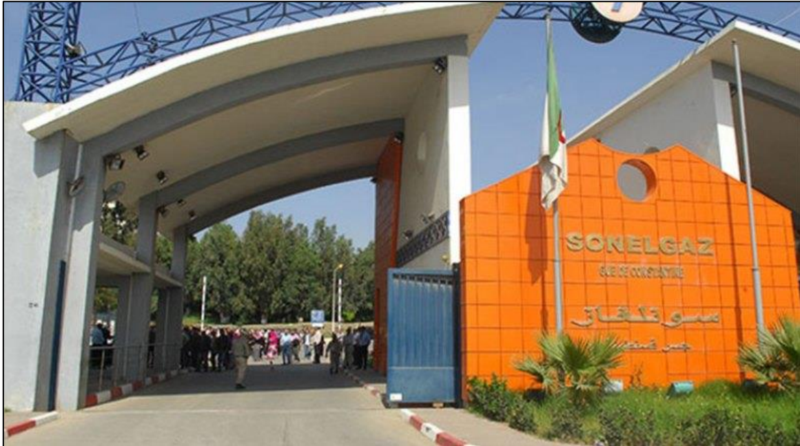
Figure 1.2 Direction générale « SONELGAZ » [18]
