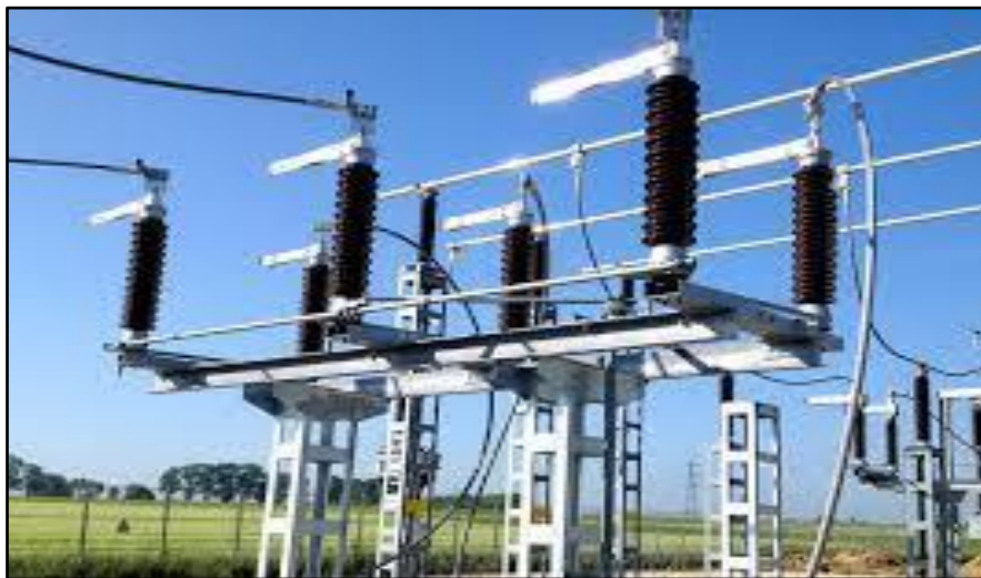
Figure1.16 Disjoncteurs de courant
