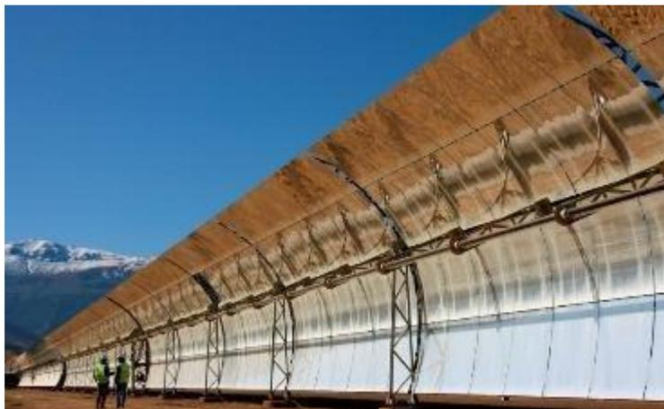
**Figure 2.15** : Système de réflecteur cylindrique parabolique avec stockage thermique à Andrasol (Espagne) [31]
