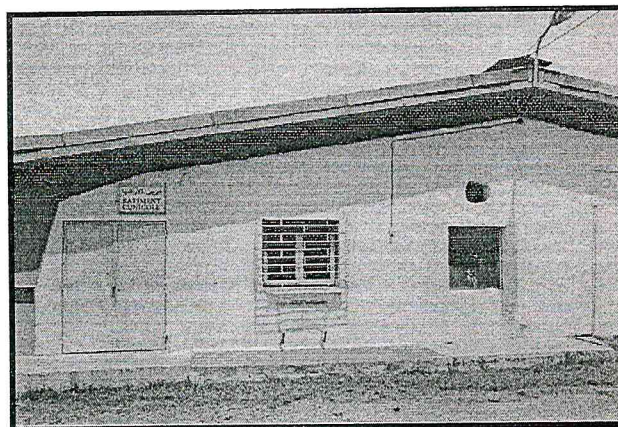
Figure 5 : Le bâtiment d'élevage (Photo personnelle).
