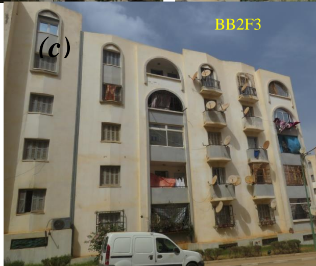
Photo IV.2. Blocs de Bâtiments N°1/ Façade 1, 2 et 3(a-c)
