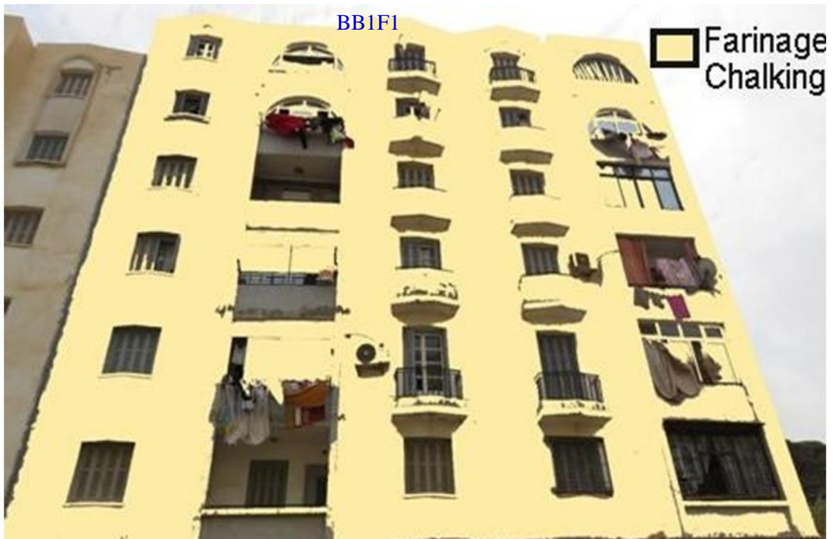
Photo IV.9. Cartographie des altérations des revêtements de peintures –farinage
