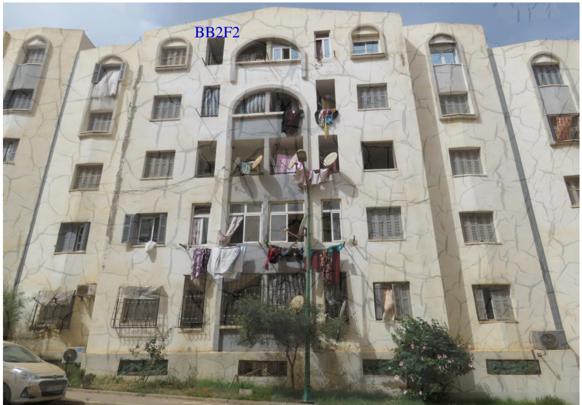
Photo IV.25. Cartographie des altérations des revêtements de peintures – craquellement
