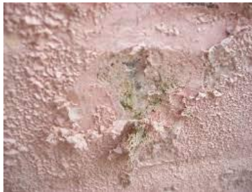
Photo II.13. Formation de boursouflure- transformation de la couche de peinture en poudre(par rabah ben abbes et zekraoui)
