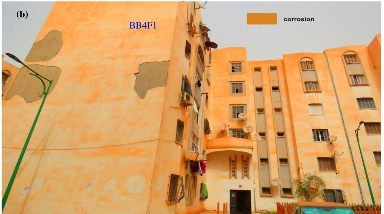
Photo IV.41. Cartographie des altérations des revêtements de peintures –changement de couleur (a- b)
