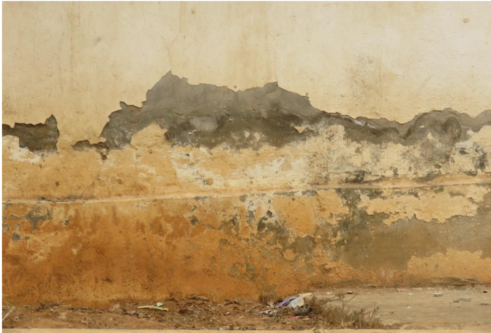
Photo IV.9. Écaillage et la couche de peinture causé par des remontées capillaires. (par l'équipe de CNERIB et rabah ben abbes & zekraoui)
