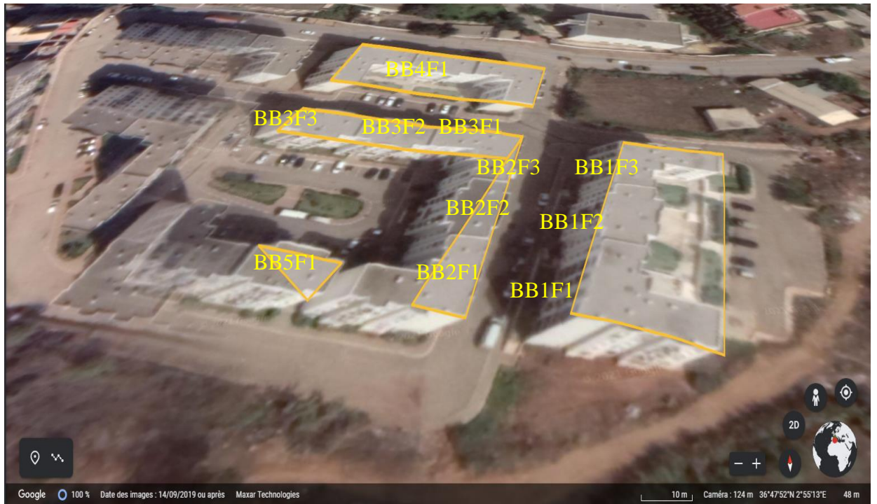
Figure IV.11. Désignation des blocs des façades de bâtiment objet de l’investigation in situ
