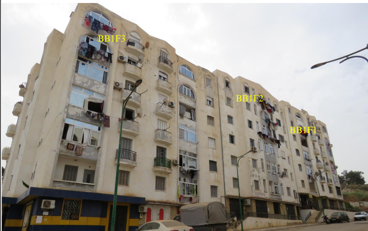
Photo IV.1. Les façades objet d'enquête - BB1F1 : Blocs de Bâtiments N°1/ Façade 1 ; BB1F2 : Blocs de Bâtiments N°1/ Façade 2 ; BB1F3 : Blocs de Bâtiments N°1/ Façade 3 Façade principale
