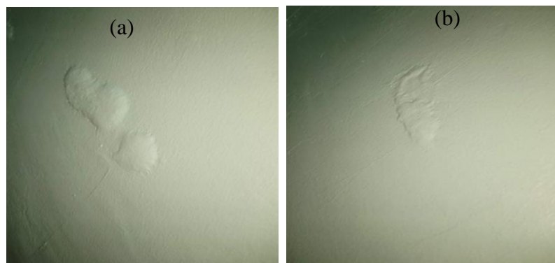
Photo II.3. Formation de cloques sur les peintures (par rabah ben abbes et zekraoui)
