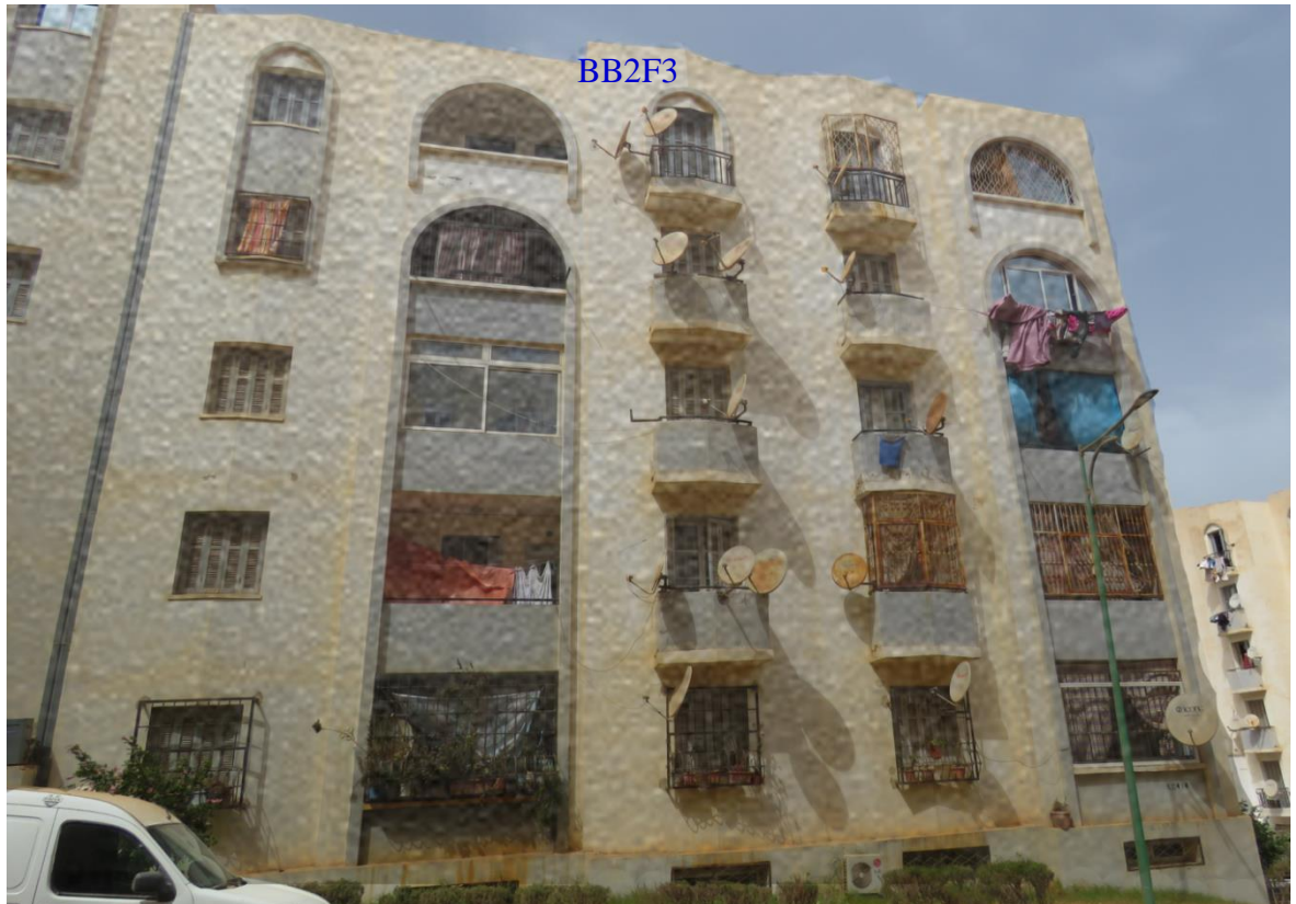
Photo IV.25. Cartographie des altérations des revêtements de peintures – craquellement
