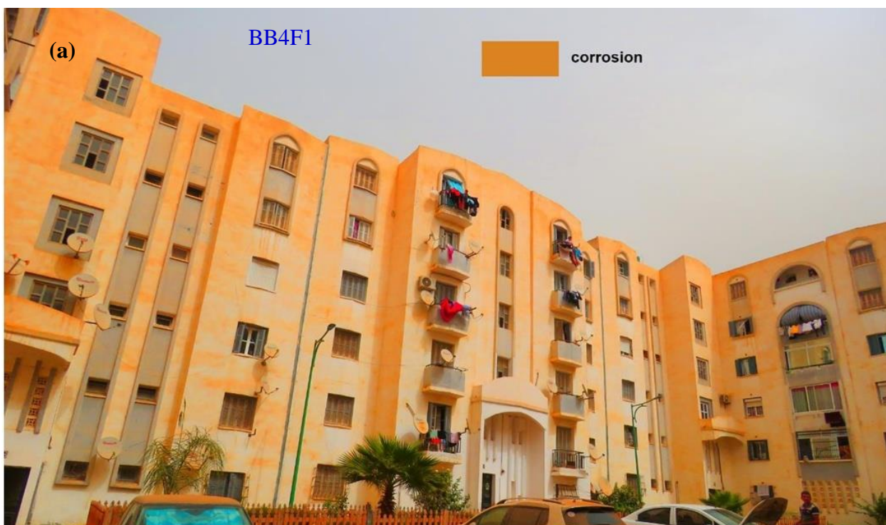
Photo IV..40. Cartographie des altérations des revêtements de peintures –Farinage
