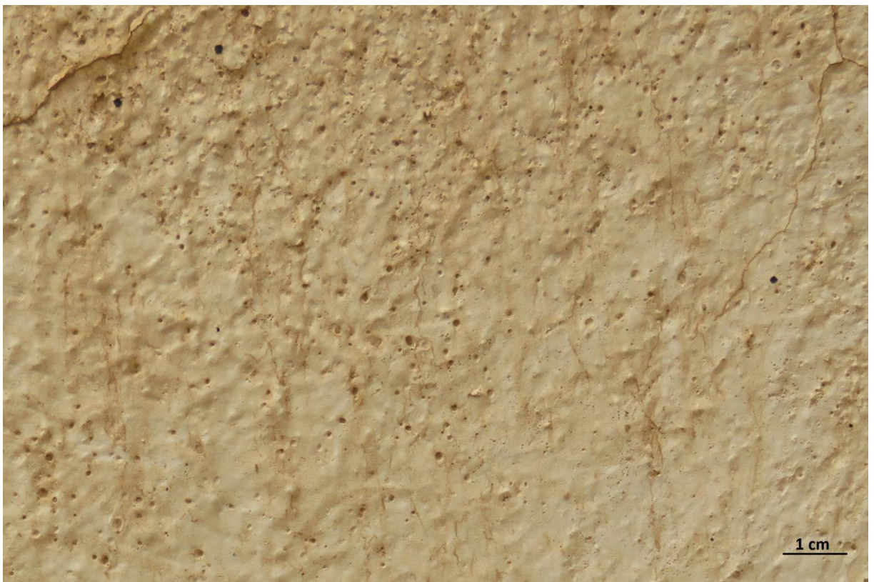
Photo IV.12. Cloques observées sur les peintures de façades des bâtiments investiguées (par l'équipe de CNERIB et rabah ben abbes & zekraoui)
