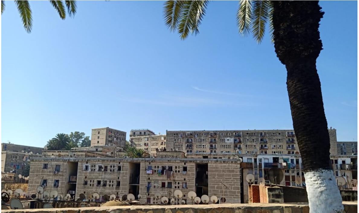
Photo I.1. Maçonnerie de pierre - façade lourde (Diar El Mahçoul, Alger) [2]
