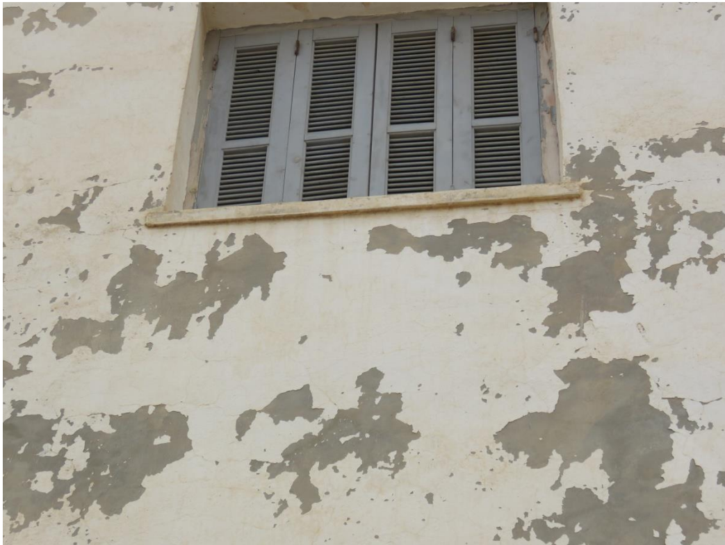
Photo IV.7. Écaillage généralisé dépassant les 30 mm de largeur (par l'équipe de CNERIB et rabah ben abbes & zekraoui)
