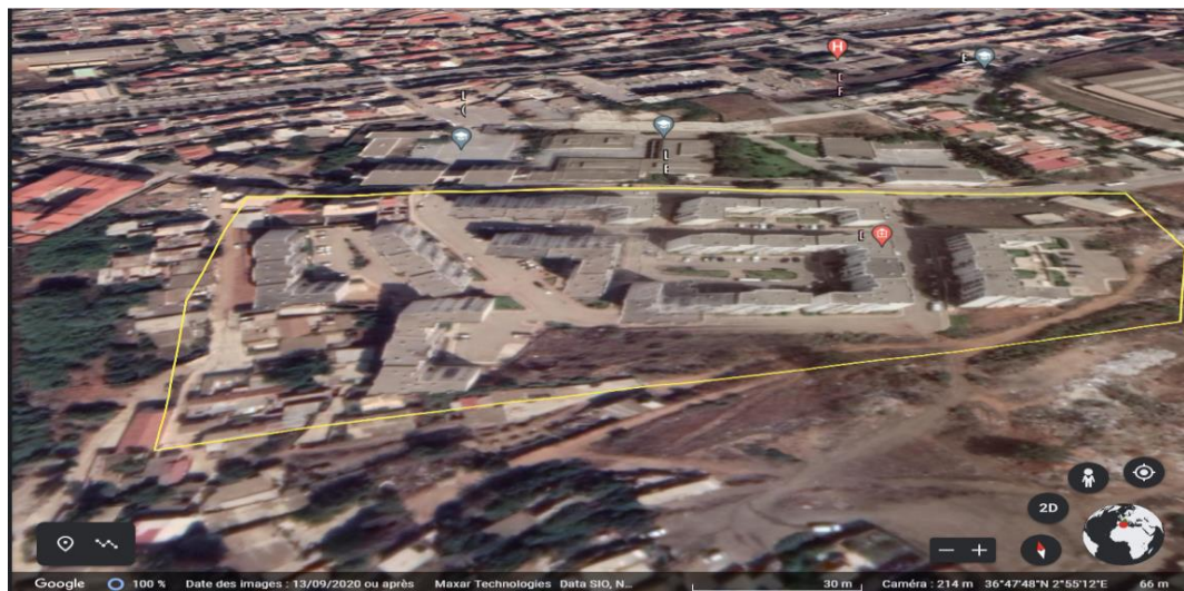
Photo III.2. Cité AADL : 400 logements choisie comme échantillon représentatif de l'étude de la dégradation des peintures de façade.
