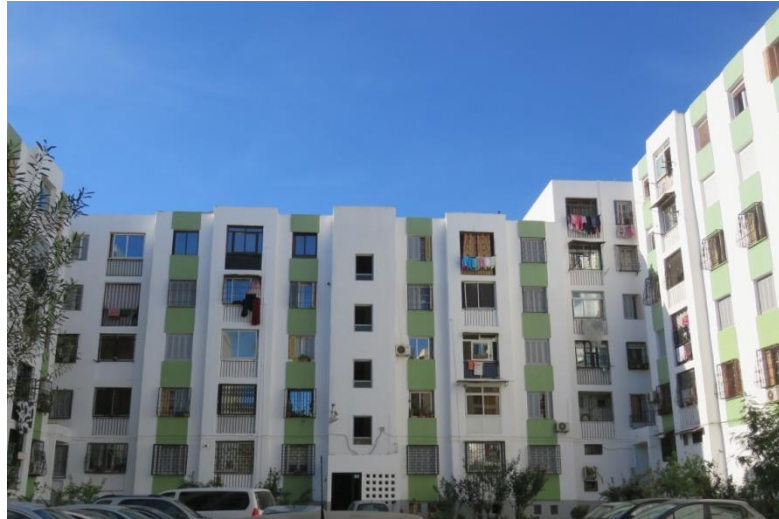
Photo I.3. Bâtiments d'habitation en béton armé avec maçonnerie de remplissage –façade lourde
