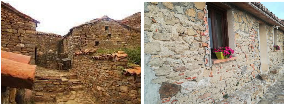
Photo I.2. Maçonnerie de moellon de pierre - façade lourde (la Kabylie) [4]
