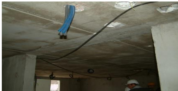
Figure 1.13. Poutre noyée
