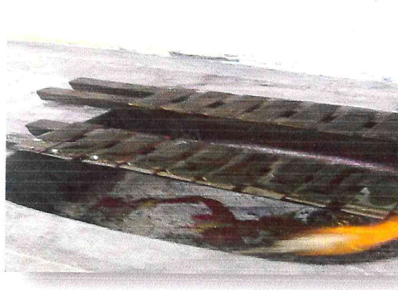
Photo n°05 : Chauffage des lames
