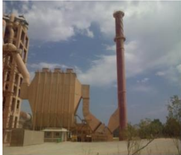
Figure A.7- Electro filtres.
