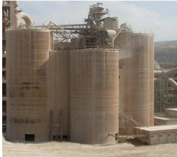
Figure 1.14 -Atelier d'homogénéisation des matières premières [1].
