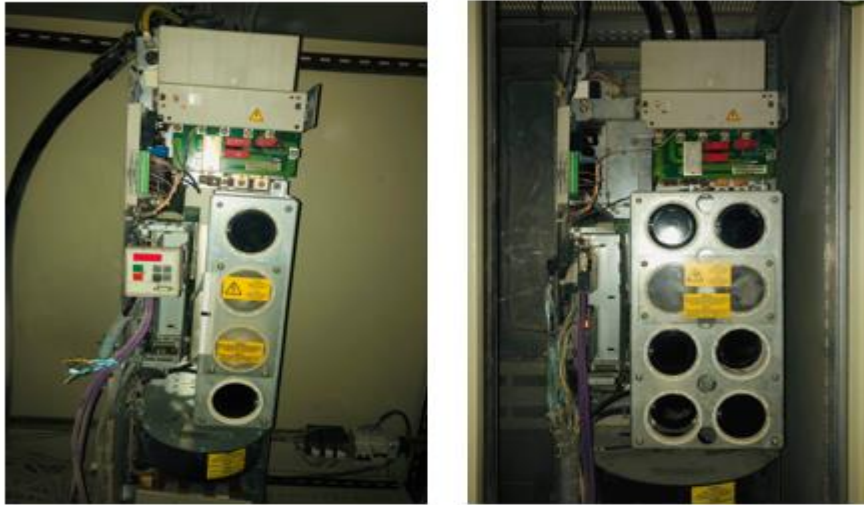
Figure 2.12–Variateurs de vitesse (maître, esclave) de l'atelier.
