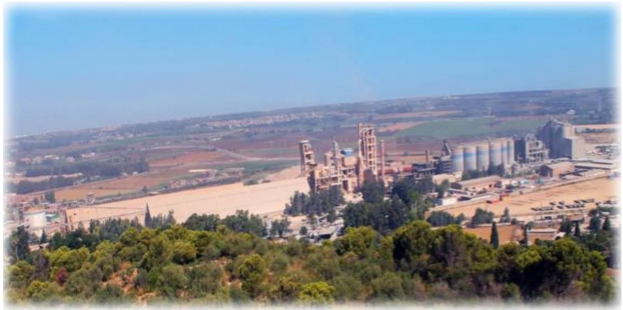
Figure A.1- Vue générale de l'entreprise
