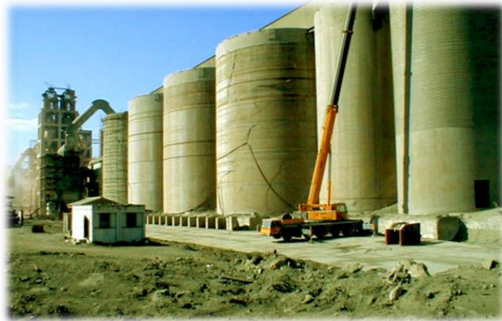
Figure 1.18 -Photo des silos de stockage du gypse, calcaire, ciment [1].
