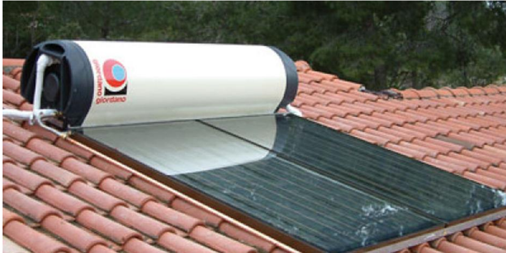
Figure 2.5 : Chauffe-eau solaire monobloc
