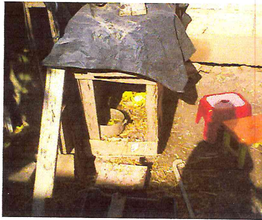
Figure (13) : bâtiment en bois région Ain defla
