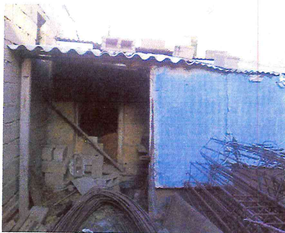
Figure (15) : bâtiment en ciment région Ain defla
