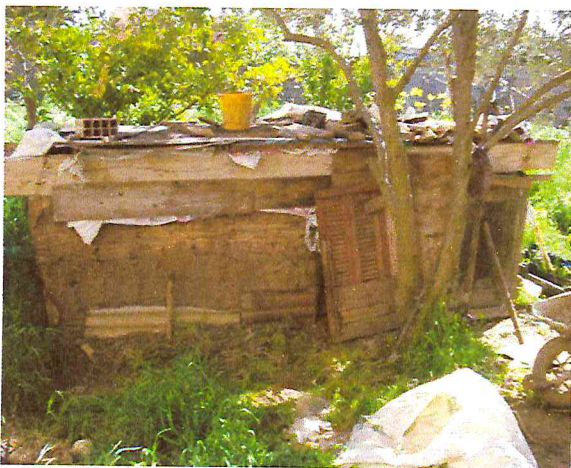
Figure (10) : bâtiment en bois région Bouira
