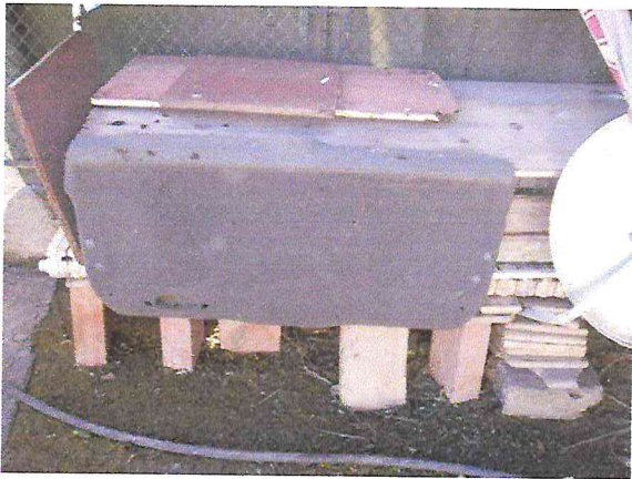
Figure (12) : bâtiment construit avec mélange métallique, bois et parpaing
