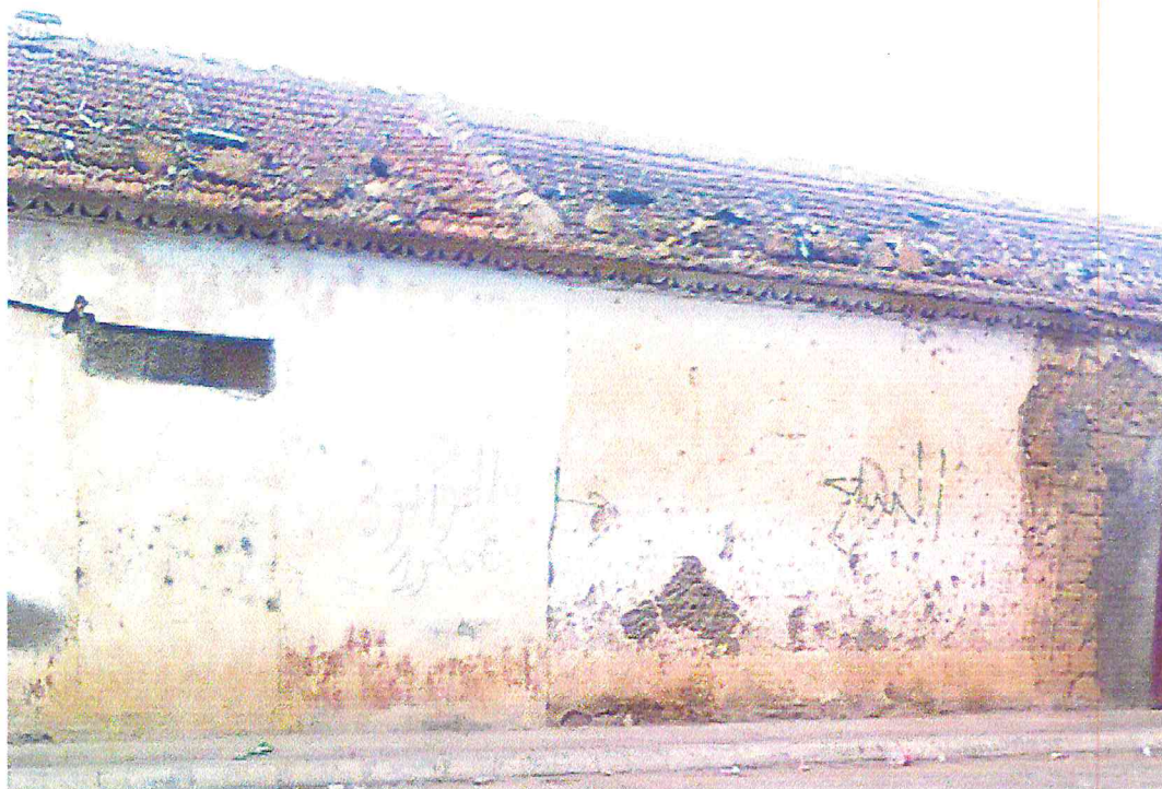
Photo 3 : la maison ancienne
