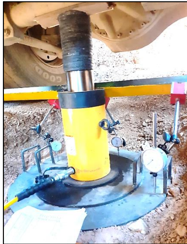
Figure I. 8: Photo de l'essais de chargement à la plaque, chantier Blida.
