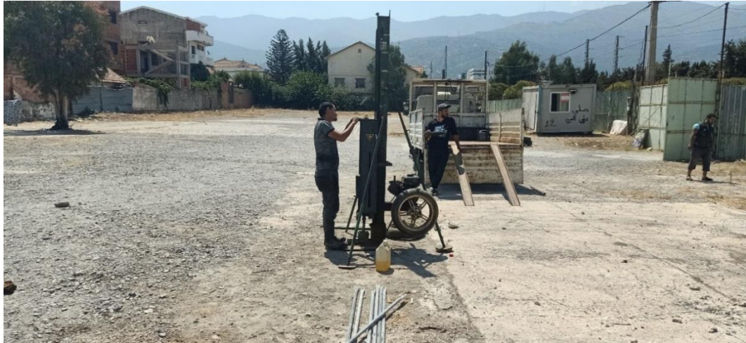
Figure II. 4: Essai au Pénétrömètre Dynamique Lourd.
